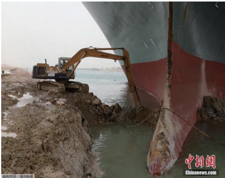
随着苏伊士运河搁浅巨型货轮的救援工作持续进行，为巨轮船头挖掘泥沙的挖掘机走红。
