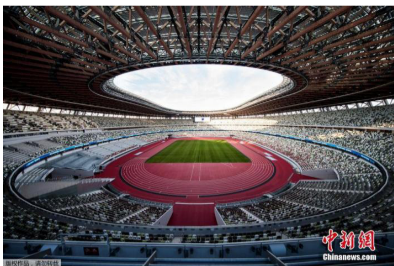
资料图:东京奥运会主体育场国立竞技场
