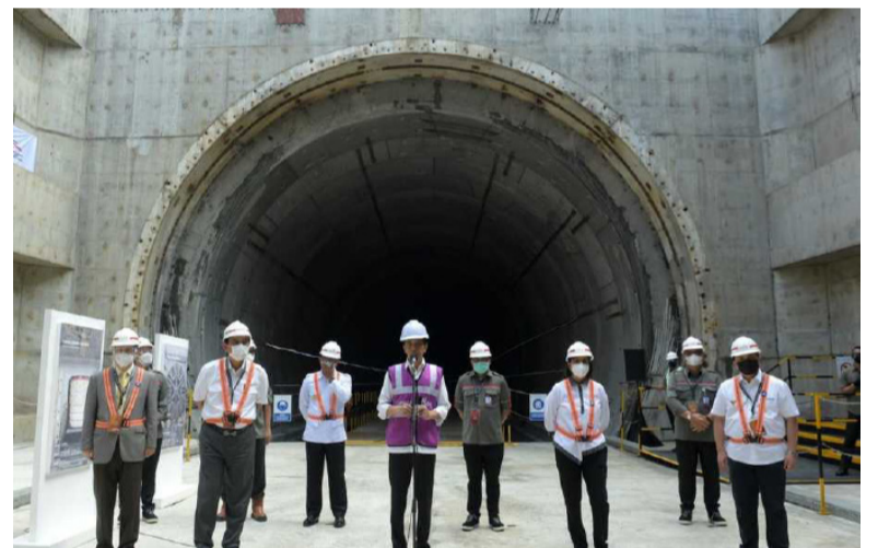
总统视察雅万高铁隧道建设，宣布明年正式通车运营。
