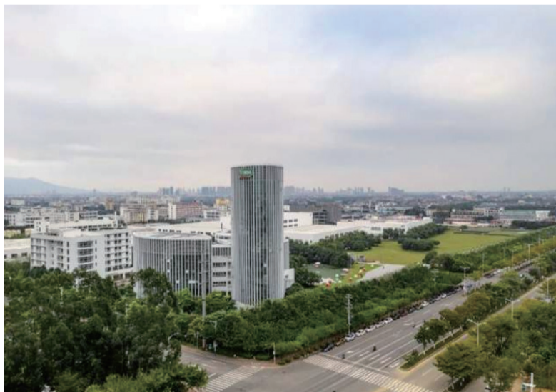
福建省莆田， 三棵树涂料股份有限公司总部
