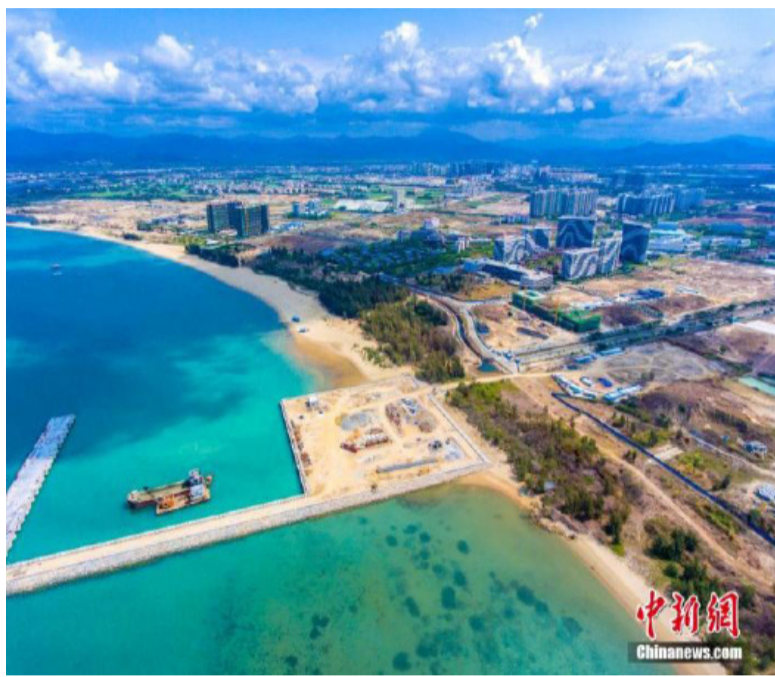
资料图：航拍三亚崖州湾科技城各大项目正在加紧建设。 骆云飞 摄
