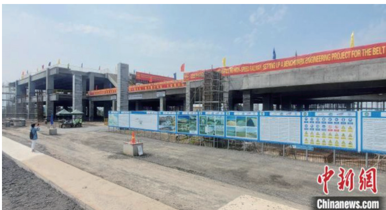
图为该车站站房主体结构。 李德明 摄
