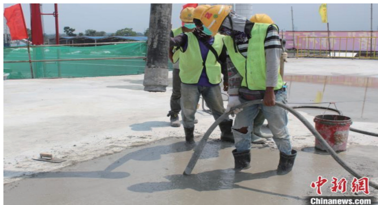
图为施工人员进行混凝土浇筑。 李德明 摄
