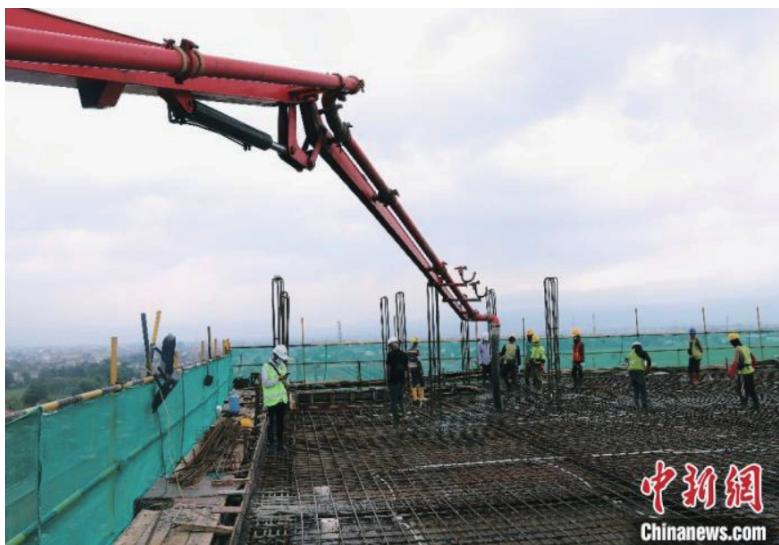
图为混凝土泵车正在进行混凝土浇筑。 李振奎 摄
