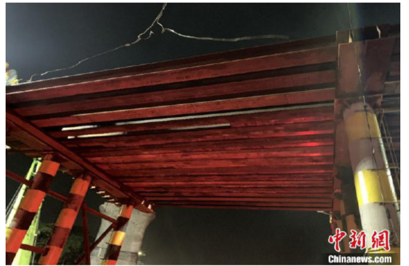
DK1203特大桥79号门式墩跨匝道H型钢吊装施工
