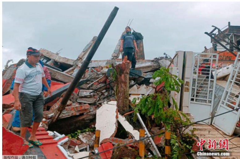
当地时间1月15日凌晨，印尼西苏拉威西省发生6.2级地震，造成大量房屋损毁倒塌。
