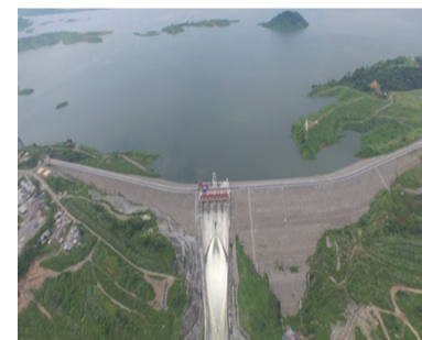
中国电建承建的重大基建工程：印尼佳蒂格德大坝
