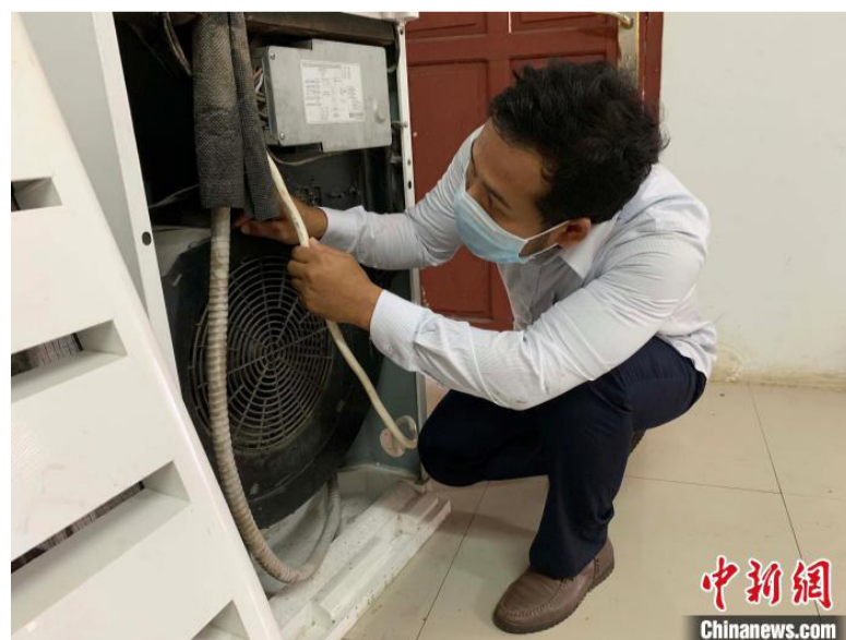
图为瑞斯基在维修空调。魏文刚 摄
