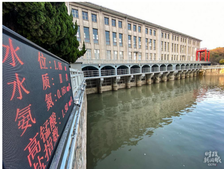
△江都水利枢纽是目前亚洲最大的泵站枢纽。(总台央视记者李辉拍摄)
