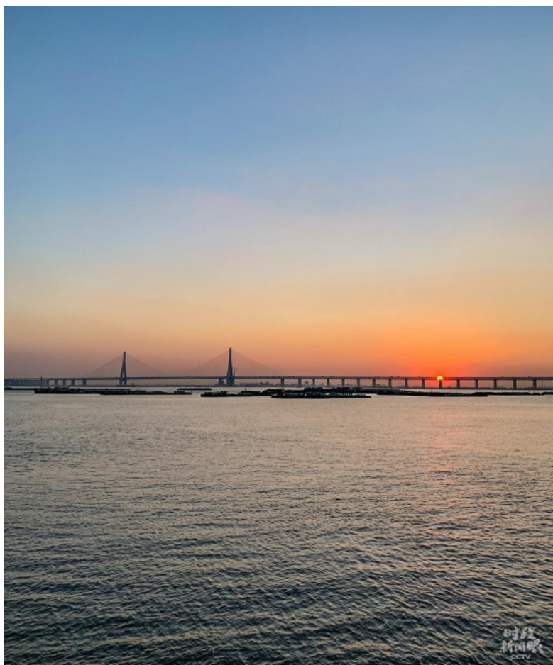
△位于南通市的沪苏通长江公铁大桥(总台央视记者杨新禹拍摄)
