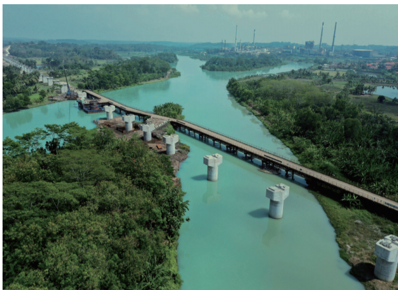
今年9月30日，由中国中铁施工的雅万高铁10号隧道安全穿越印尼百年米轨既有铁路线，在雅万高铁全线控制性、重难点工程上取得又一突破性进展。图为9月24日，雅万高铁DK655 特大桥施工现场。中新社
