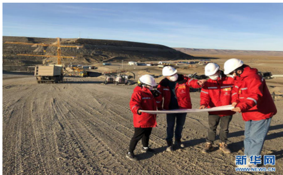
4月22日，中国工程师在阿根廷孔多克里夫与拉巴朗科萨水电站施工现场讨论施工方案。新华社发（中国能建葛洲坝集团阿根廷孔拉水电站项目部供图）
