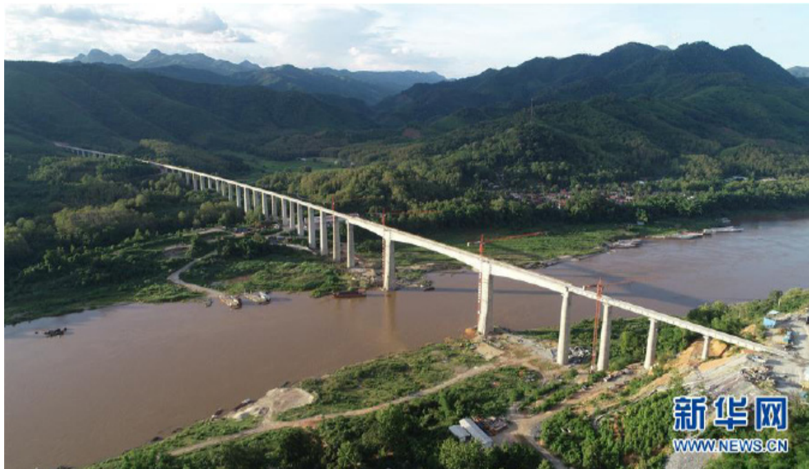
这是7月15日在老挝拍摄的中老铁路班纳汉湄公河特大桥。新华社发（梅征友摄）
