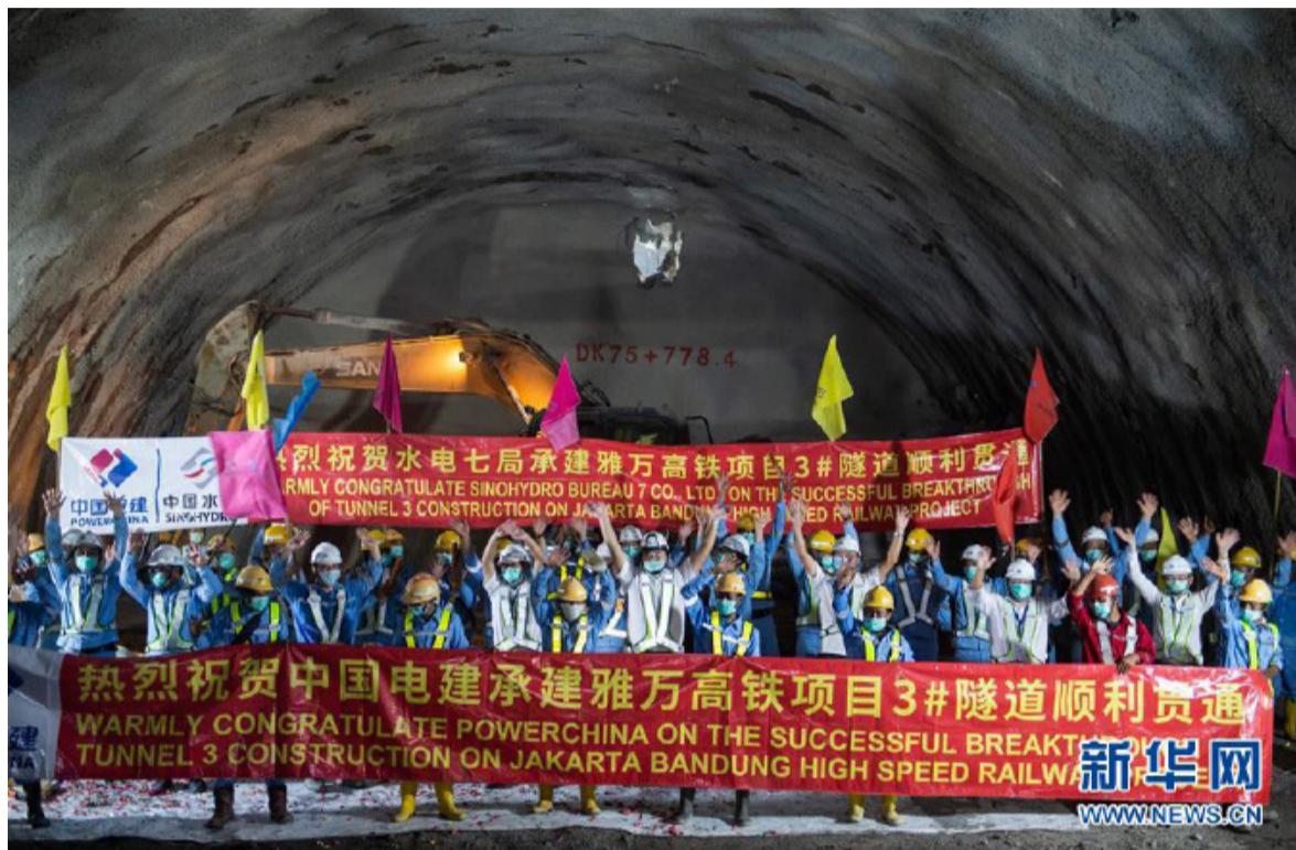
4月26日，在印度尼西亚雅万高铁3号隧道，工人们庆祝隧道贯通。
