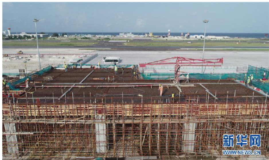
这是在马尔代夫首都马累拍摄的中国港湾承建的维拉纳国际机场改扩建项目施工现场（6月24日摄）。新华社发（中国港湾马尔代夫维拉纳国际机场改扩建项目部供图）
