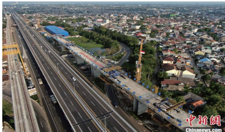
8月15日下午,印尼雅万高铁1号梁场架梁通道6个刚构连续梁同时合龙。标志着该项目全线首个架梁通道形成,为首个架梁段连续架梁创造了条件。图为DK15处5个连跨刚构连续梁顺利合龙。中新社发 中国电建雅万项目部供图
