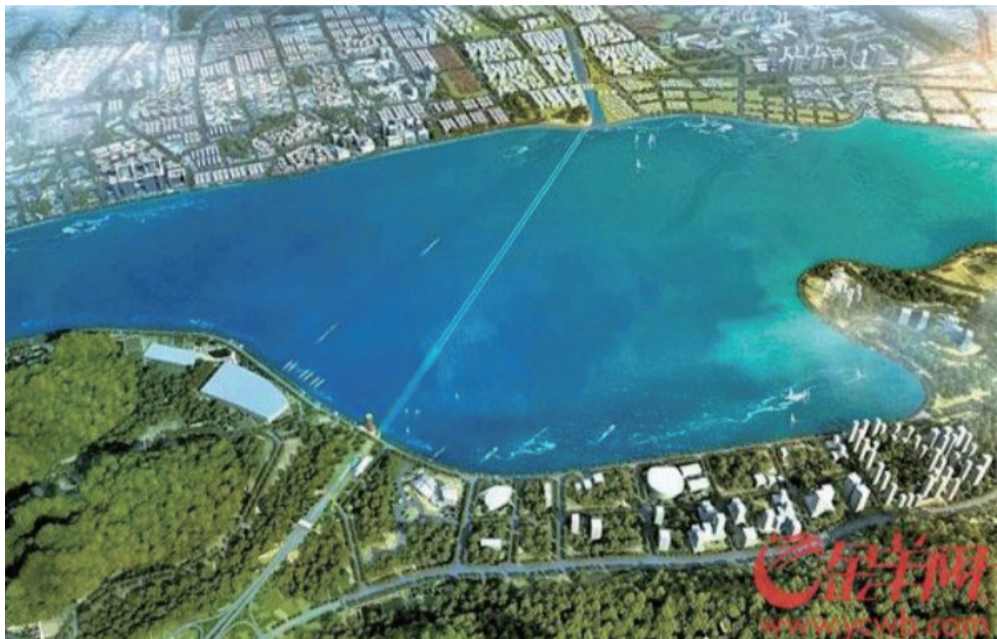
汕头海湾隧道建设地点位于 汕头海湾大桥和礮石大桥之间
