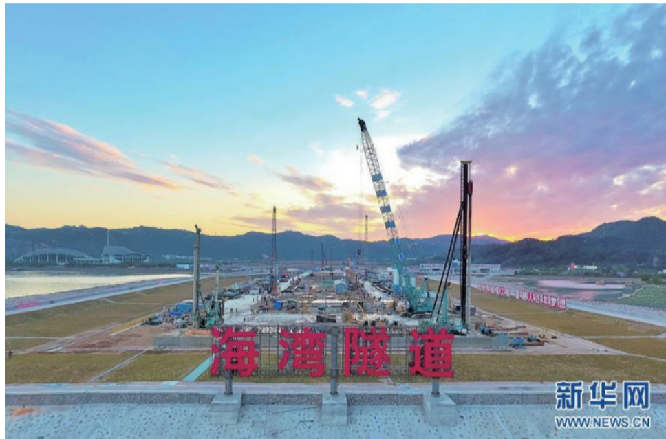
汕头海湾隧道施工现场 (8月6日摄)。新华社发
