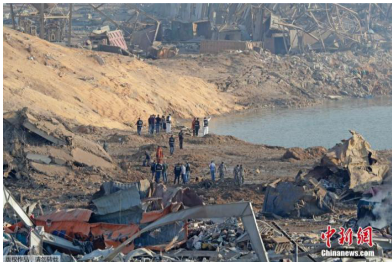
俯瞰黎巴嫩爆炸现场，建筑物被夷平。
