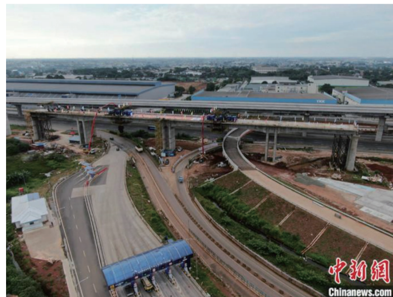
资料图为5月10日，印尼雅万高铁2号特大桥多跨刚构连续梁顺利合龙。
