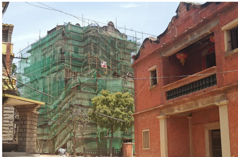
梧林传统村落的部分古建筑仍在修缮中。吴冠标 摄
