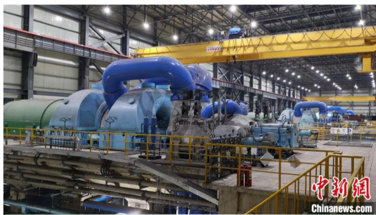
图为印尼德龙工业园二期发电厂。周渊 摄
