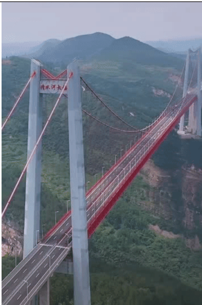
世界排名No.6大桥： 清水河大桥，主跨1130米，高406米，亚洲第一山区双塔单跨钢桁悬索桥。
