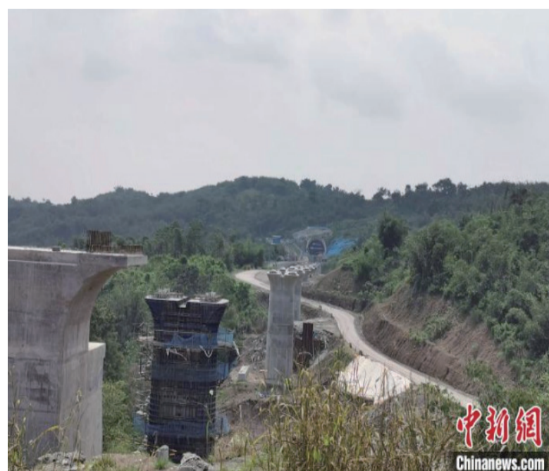
图为雅万高铁3号隧道位置。 中国电建雅万高铁项目部 供图
