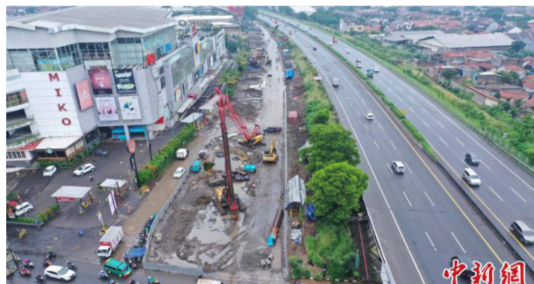
图为“卡脖子”工程开始施工。中国中铁印尼雅万高铁项目部供图
