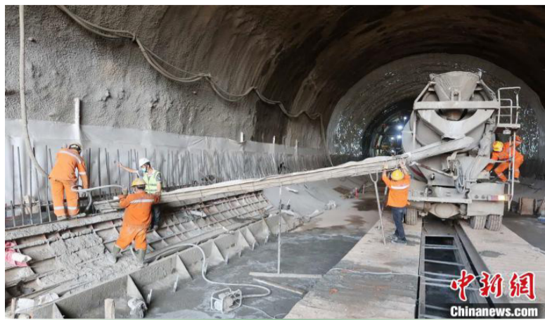
图为中国中铁印尼雅万高铁项目部隧道施工。中国中铁印尼雅万高铁项目部供图
