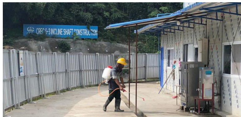
图为生活区定时定点消毒。中国中铁印尼雅万高铁项目部供图
