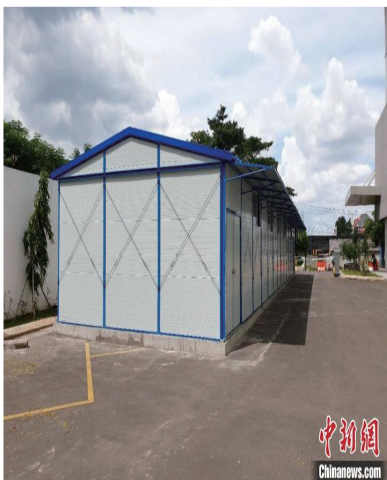
图为已建好的应急隔离病房板房。 印尼宏大建筑 供图 摄
