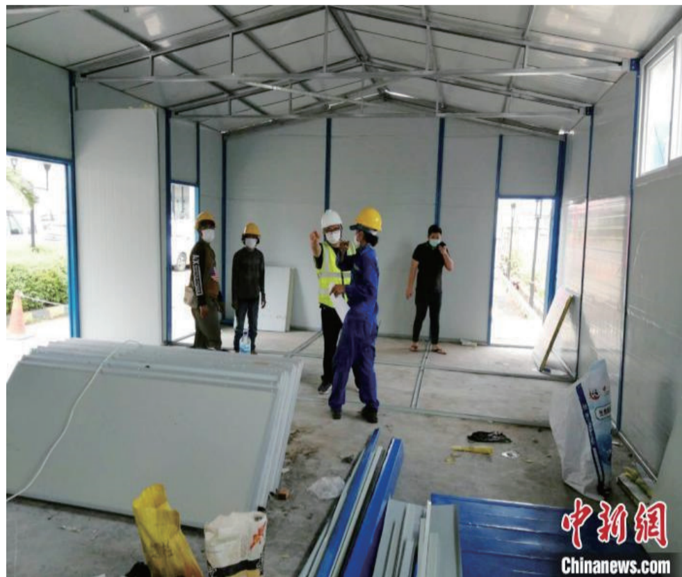
图为应急隔离病房板房建设中。 印尼宏大建筑 供图 摄
