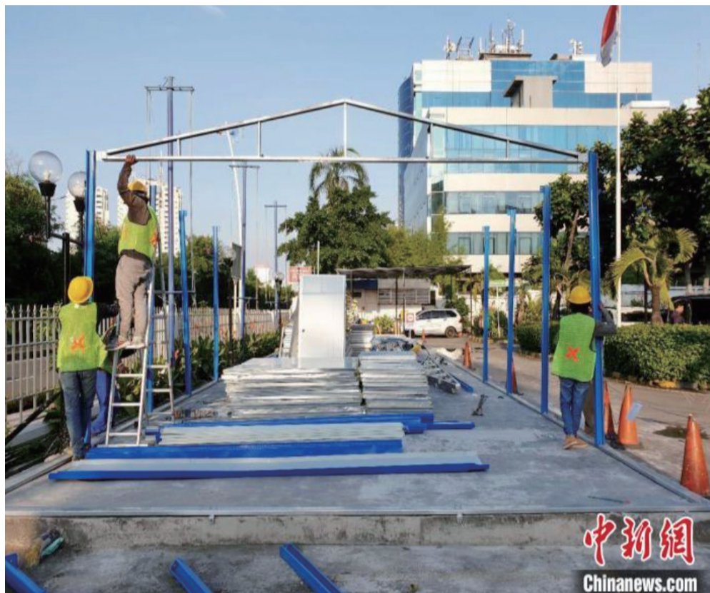
图为应急隔离病房板房建设中。 印尼宏大建筑 供图 摄
